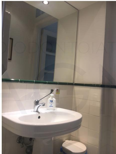
Nella toilette degli ospiti, l'accensione della luce avviene **senza interruttori ma mediante un sensore**, la rubinetteria è a gomito tipo ospedaliero, e le mani sono asciugate con fazzoletti di carta.
